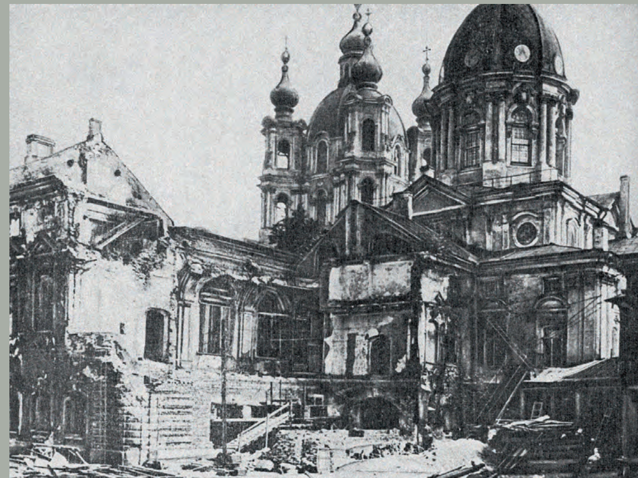
Смоленский монастырь. Разрушенный юго-западный корпус Фото 1946
